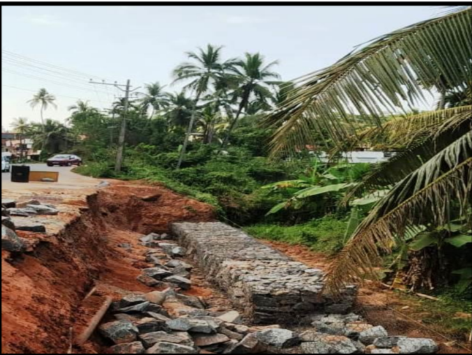
Gabion 3 rd Layer @ Ch : 22+312 – 22+336 RHS
