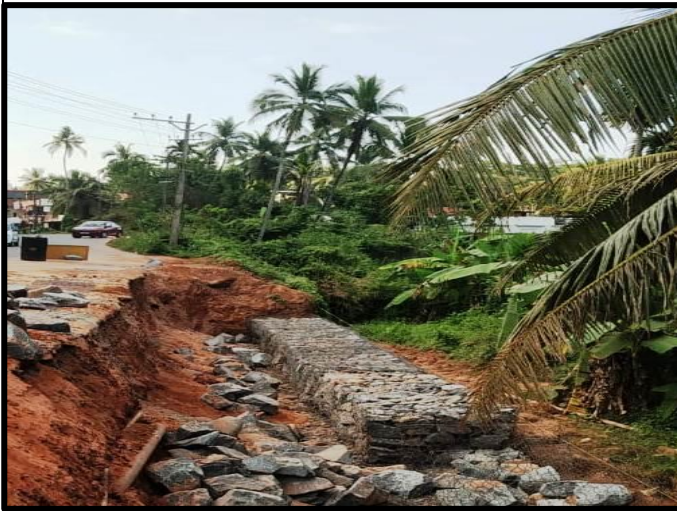
Gabion 3 rd Layer @ Ch : 22+312 – 22+336 RHS
