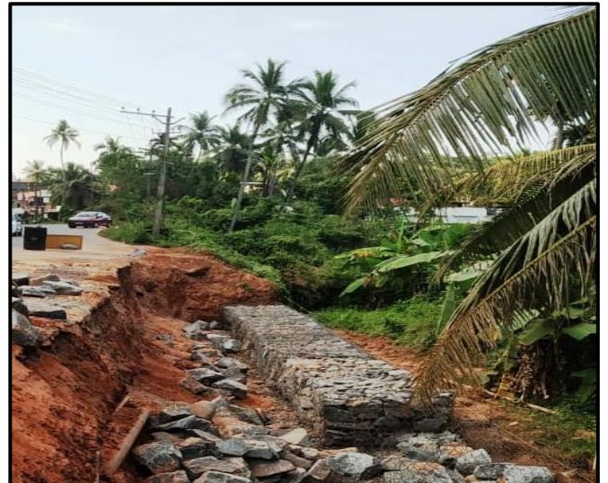
Gabion 3 rd Layer @ Ch : 22+312 – 22+336 RHS
