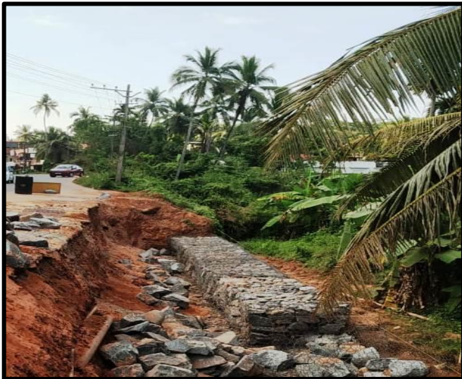
Gabion 3 rd Layer @ Ch : 22+312 – 22+336 RHS
